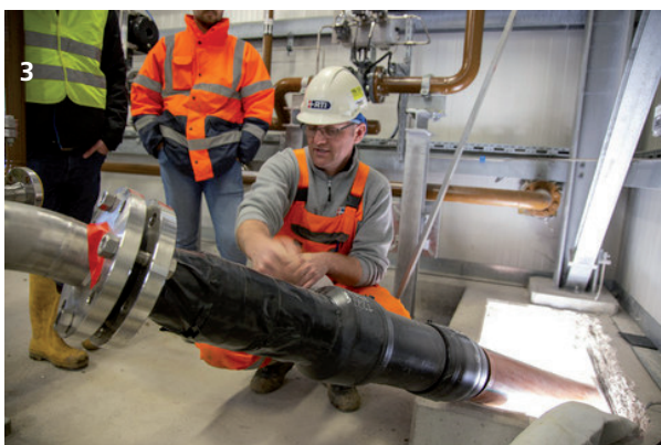
Foto 3. Se instaló un sistema de detección de fugas en el hueco anular de la caseta de la bomba
