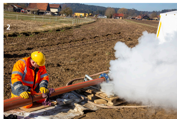
Foto 1. Tubo de contención doble de AGRU compuesto por un tubo de barrera multicapa Sureline IV estanco a la difusión (interior) y un tubo de camisa de protección Sureline III (exterior)
