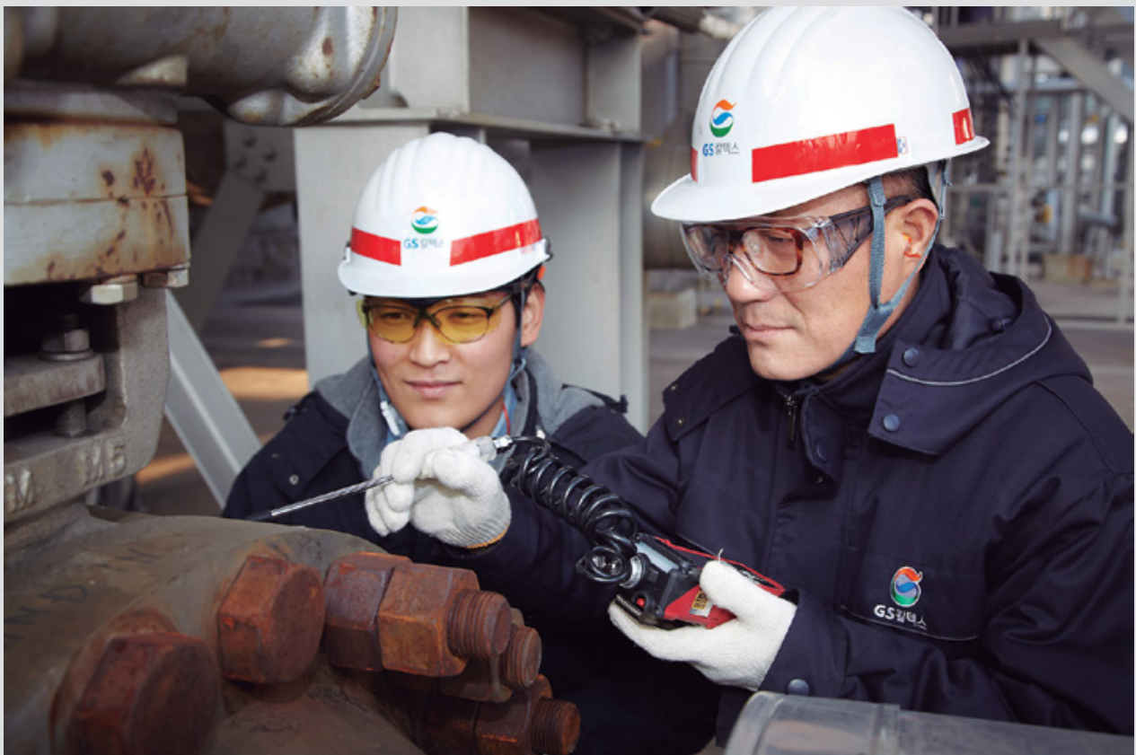
Foto 1. Ingeniero de confiabilidad revisando una instalación.
