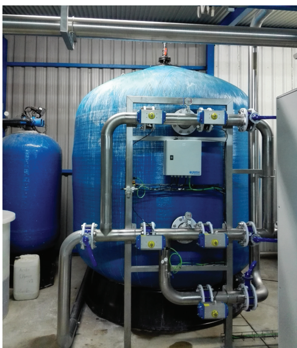
Foto 2. Frontal filtración
