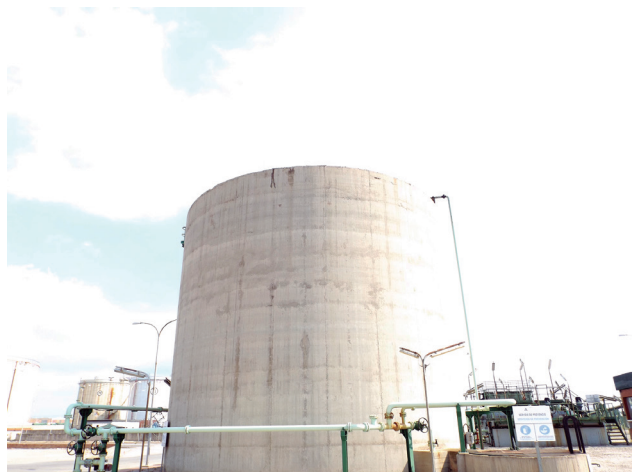
FIGURA 1. Panorámica exterior del filtro percolador de Asesa en la planta de Tarragona
