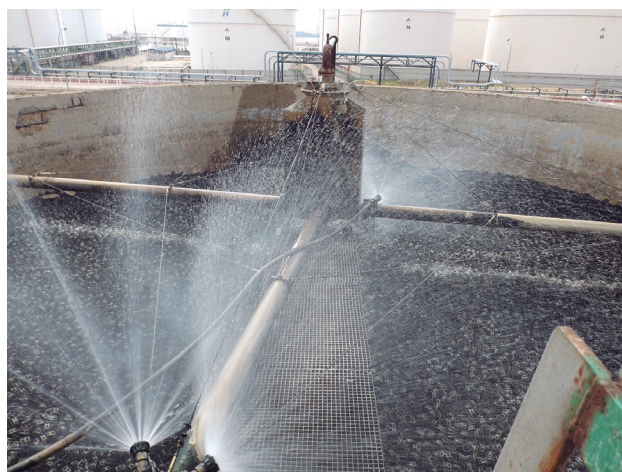
FIGURA 2. Detalle de la aspersión del agua en el filtro percolador. En la base pueden verse los cuerpos de relleno DEP LAM
