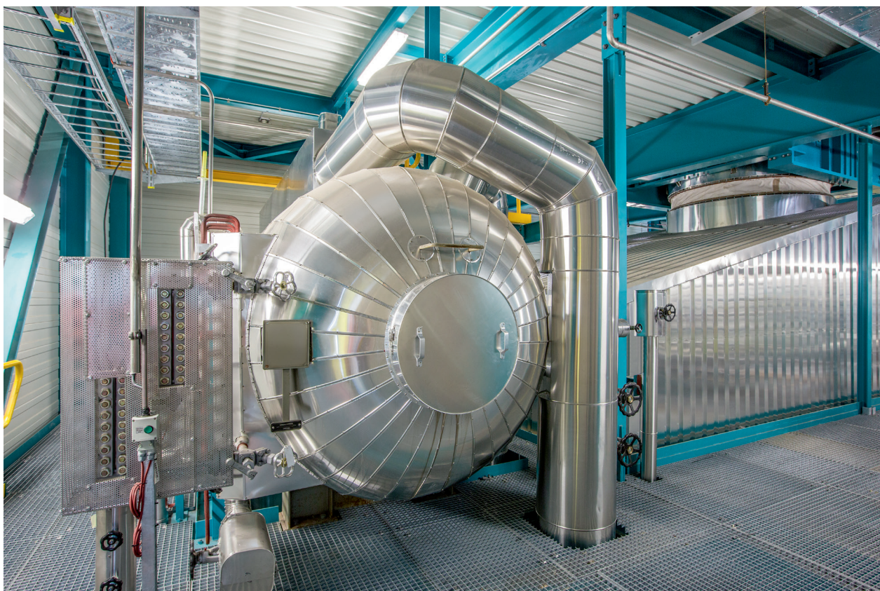
Caldera de recuperación en una central eléctrica de turbinas de gas y de vapor. Utiliza el calor residual de las turbinas de gas para generar vapor para la turbina de vapor
