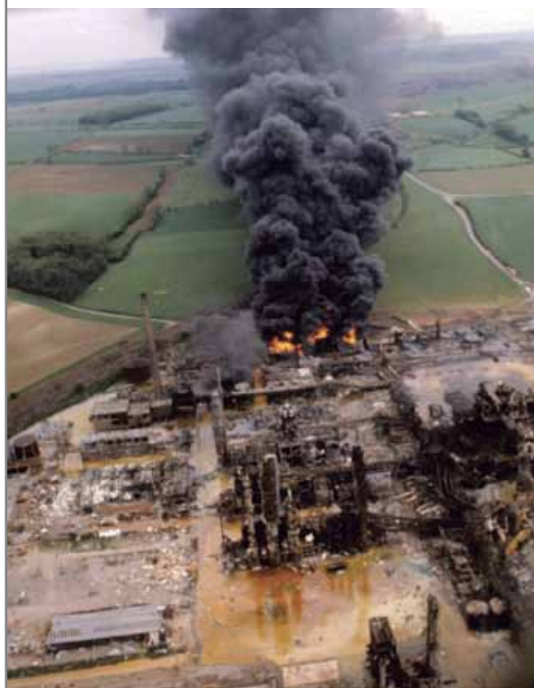
Foto 1. Imagen aérea de la planta siniestrada en Flixborough
