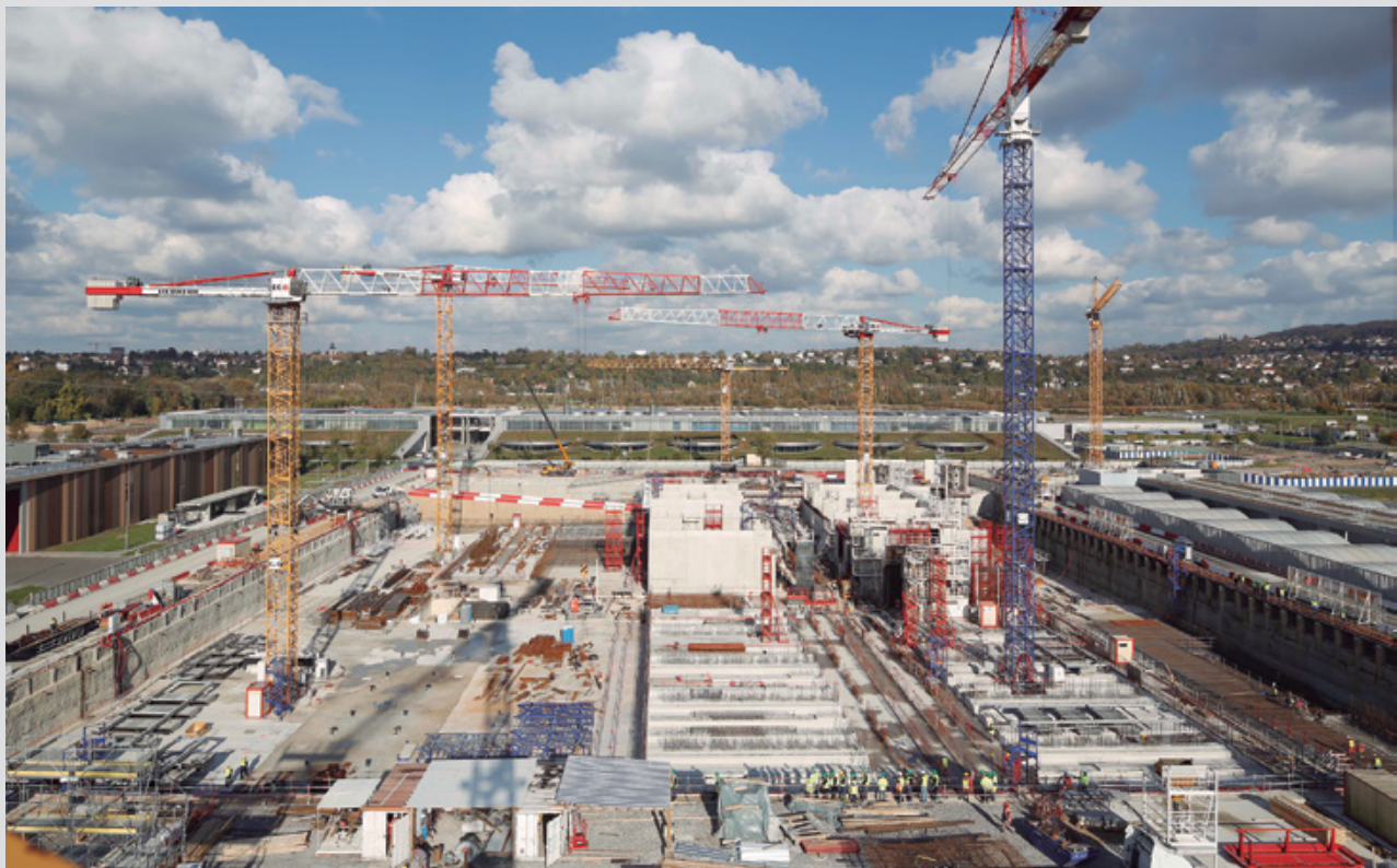
Trabajos de construcción en curso en la planta de tratamiento de aguas residuales de Achères, a las afueras de París. Fotografía por cortesía de OTV y Degrémont.
