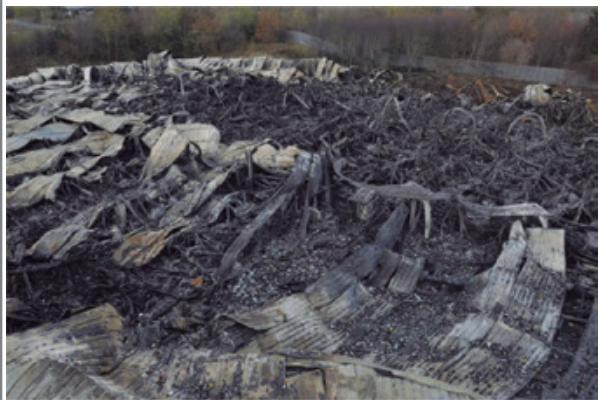
Figura 4. Resultado del incendio y las explosiones registradas
