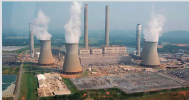
Foto 1. Central térmica carbón
