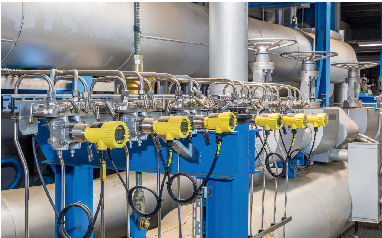
Foto 2. La solución en temperaturas ambientes muy variables: medición de presión diferencial electrónica con dos transmisores de presión de la serie VEGABAR 80
