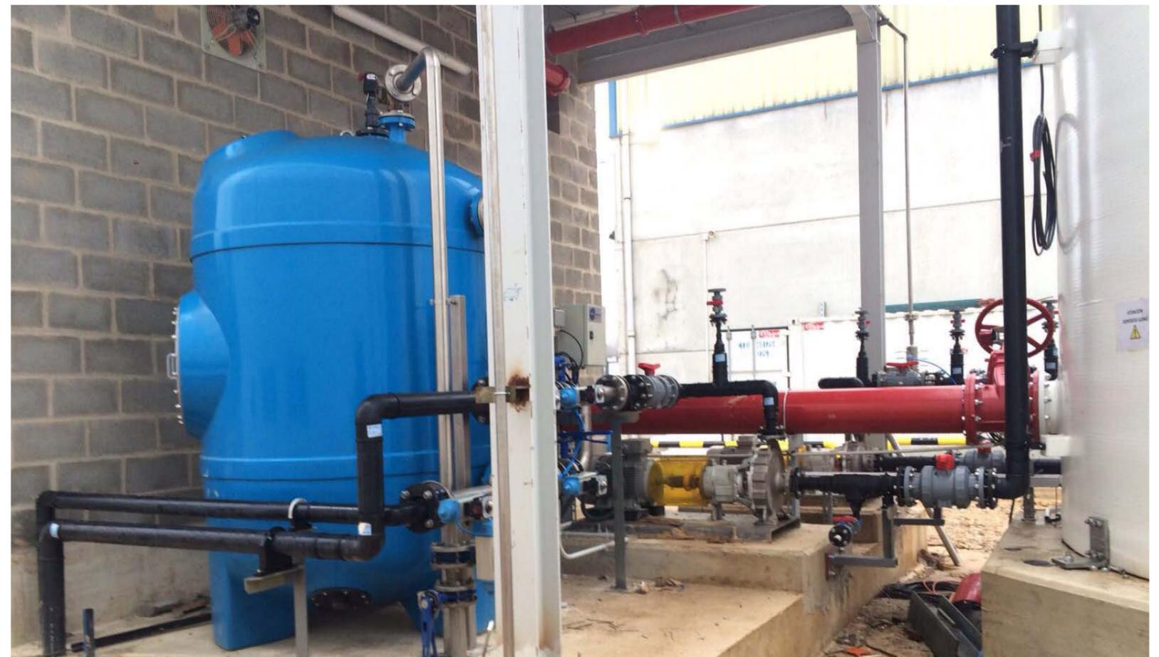
Instalación de líneas de ácido sulfúrico, hipoclorito de sodio y agua para la nueva planta de fabricación de resina
