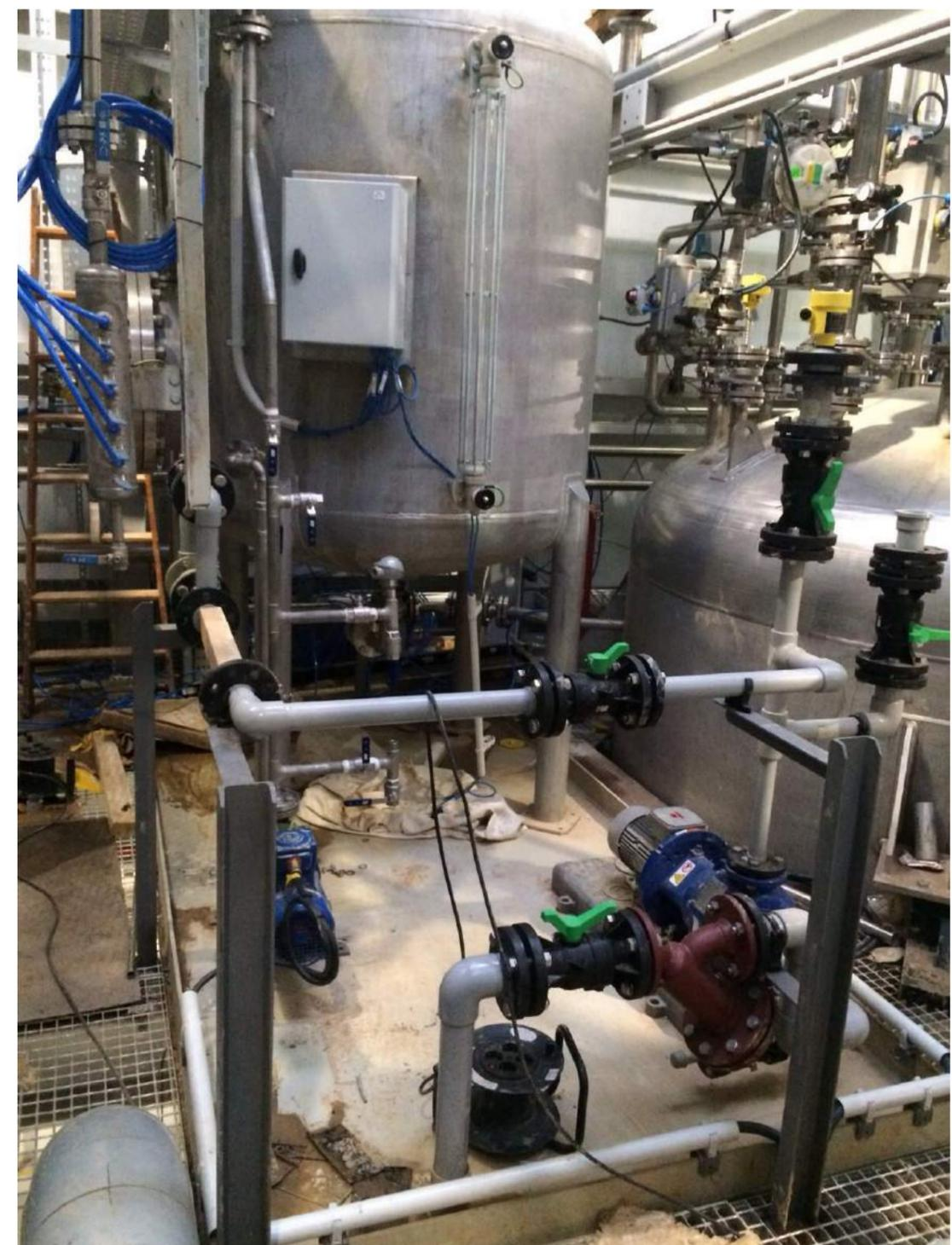
Instalación de líneas de ácido sulfúrico, hipoclorito de sodio y agua para la nueva planta de fabricación de resina
