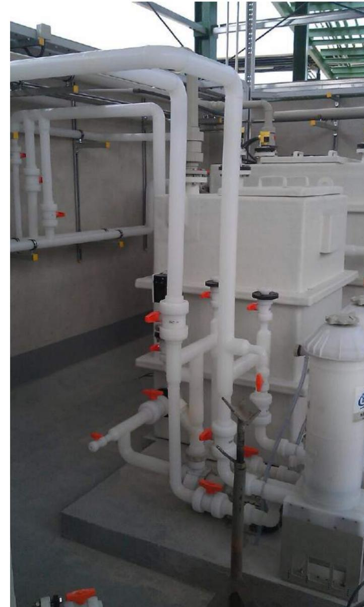
Instalación PVDF con soldadura infrarrojos
