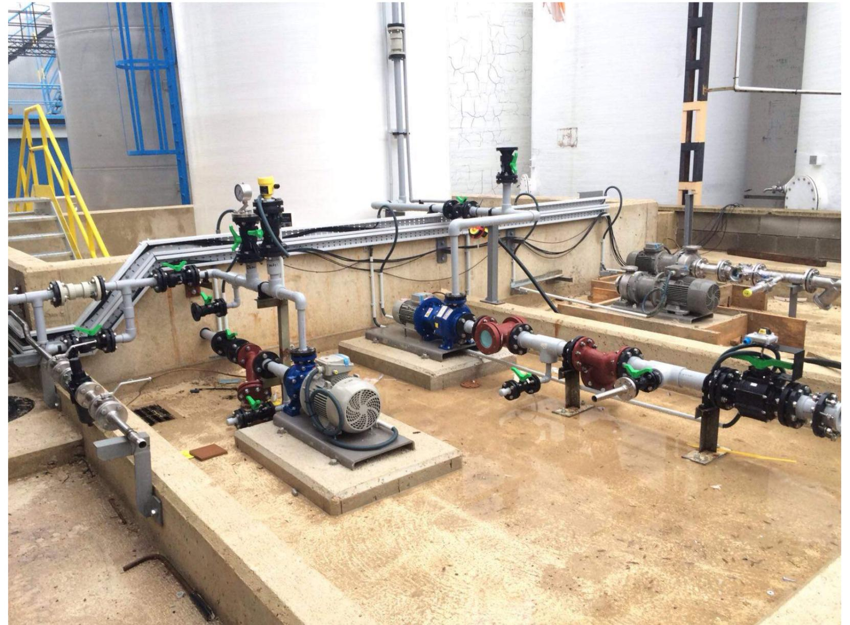
Instalación de líneas de ácido sulfúrico, hipoclorito de sodio y agua para la nueva planta de fabricación de resina
