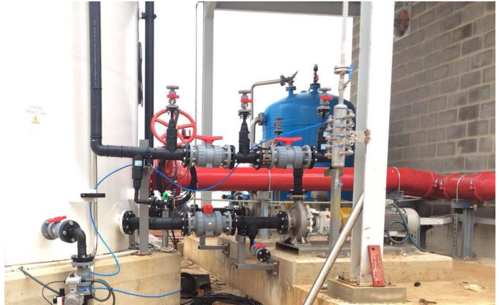
Instalación de líneas de ácido sulfúrico, hipoclorito de sodio y agua para la nueva planta de fabricación de resina
