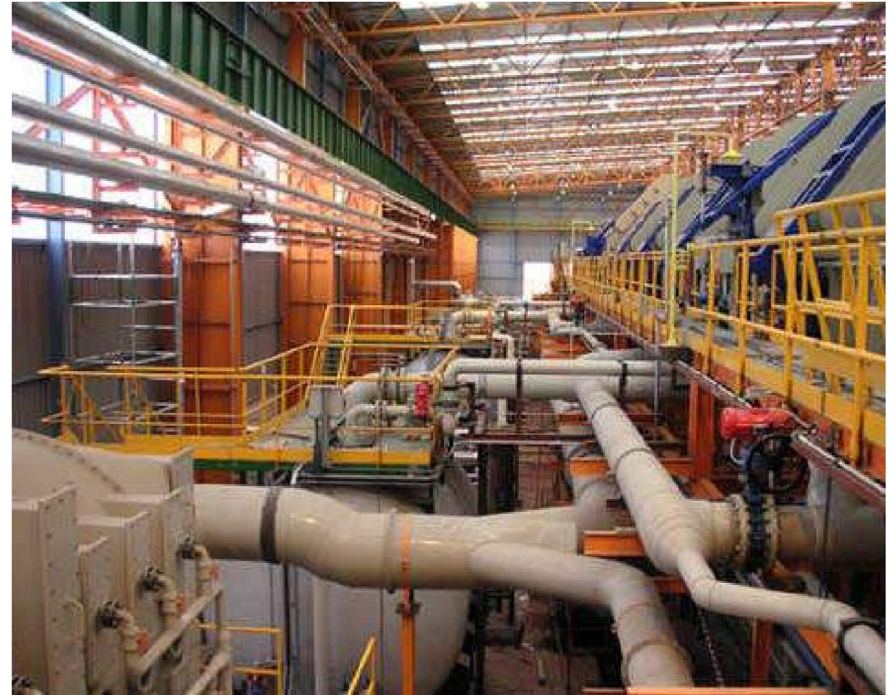
Distribución de ácidos (Polipropileno) en planta de decapado
