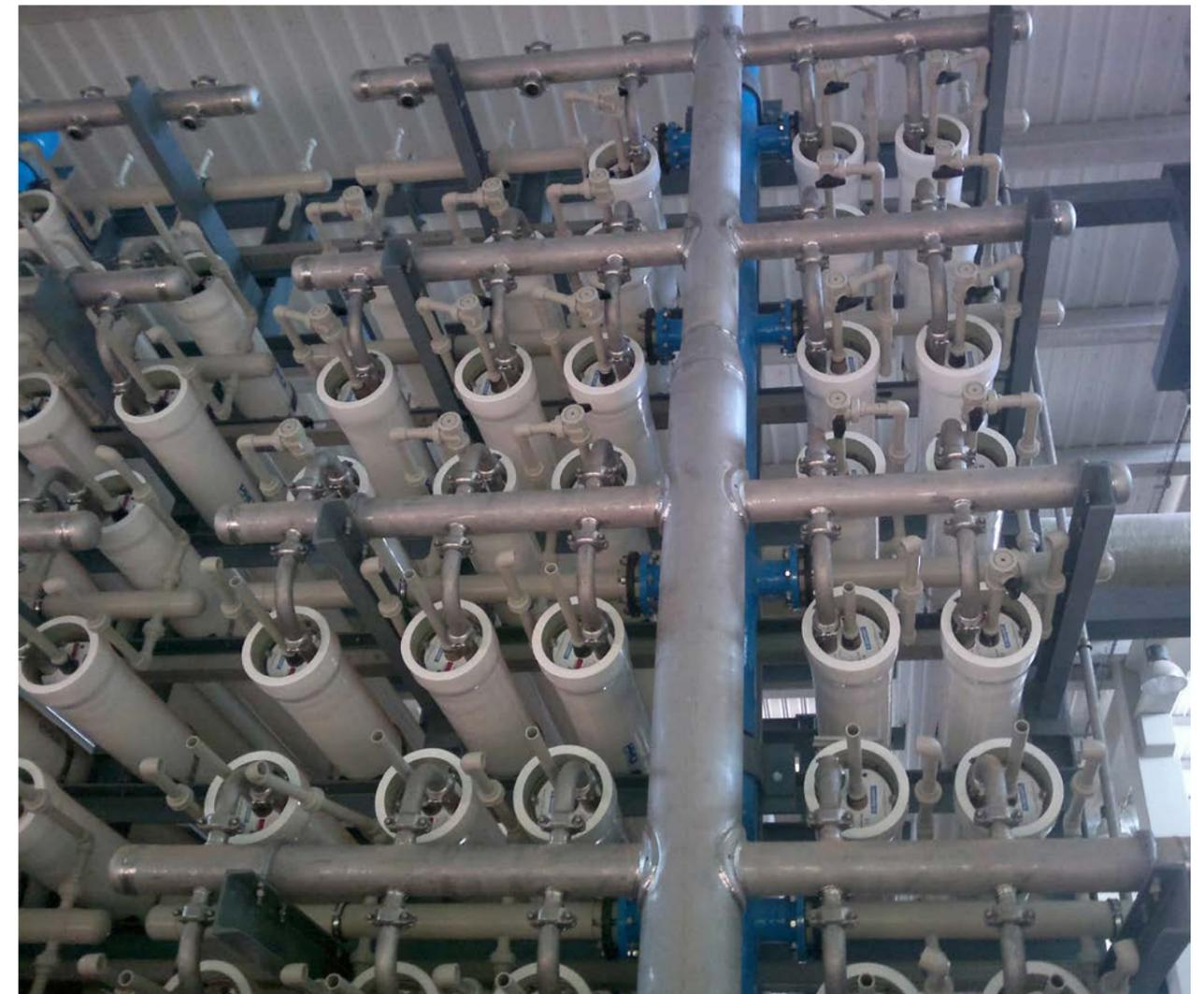
Distribución hidráulica del permeado en desaladora
