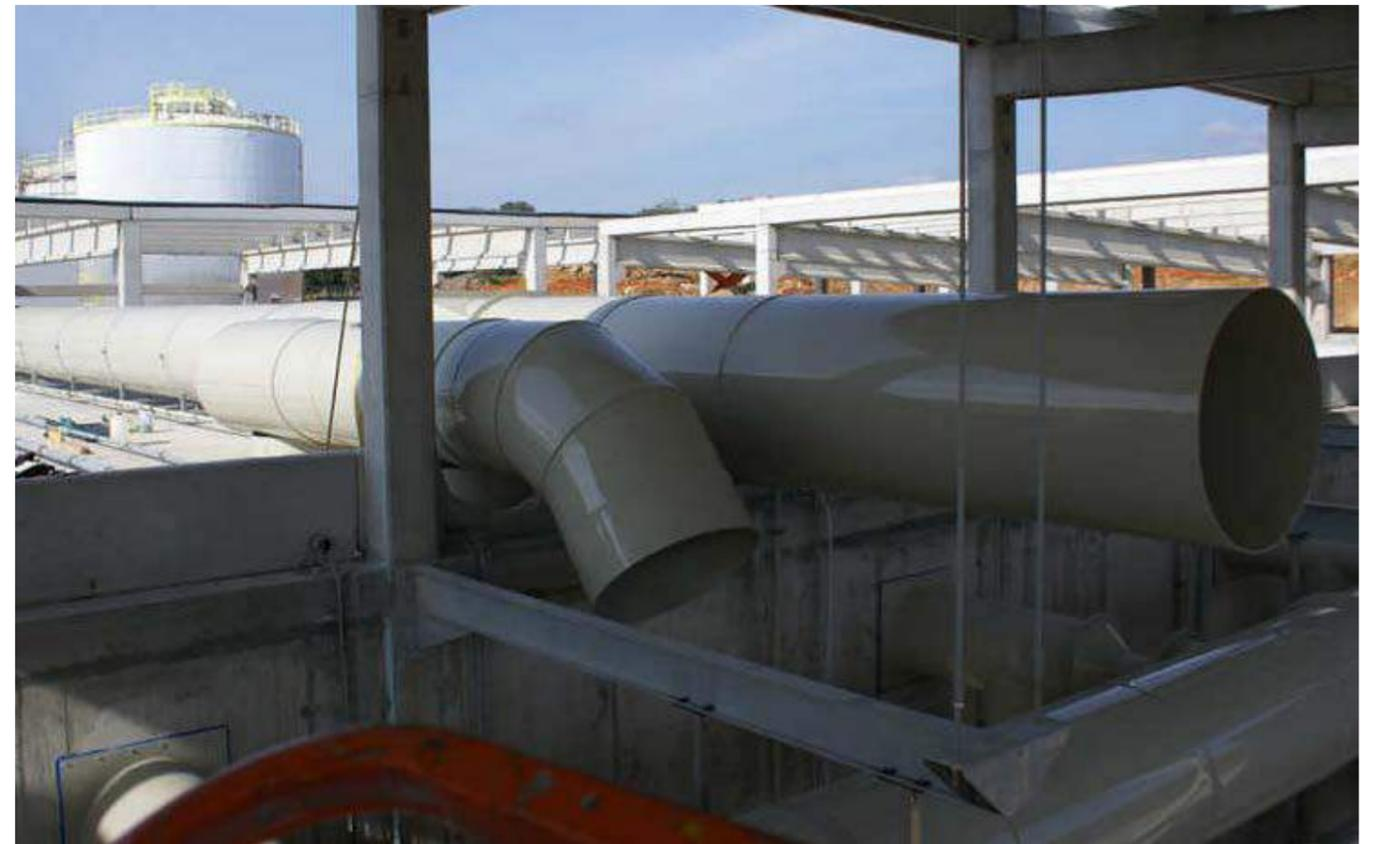
Aireación en planta de compostaje
