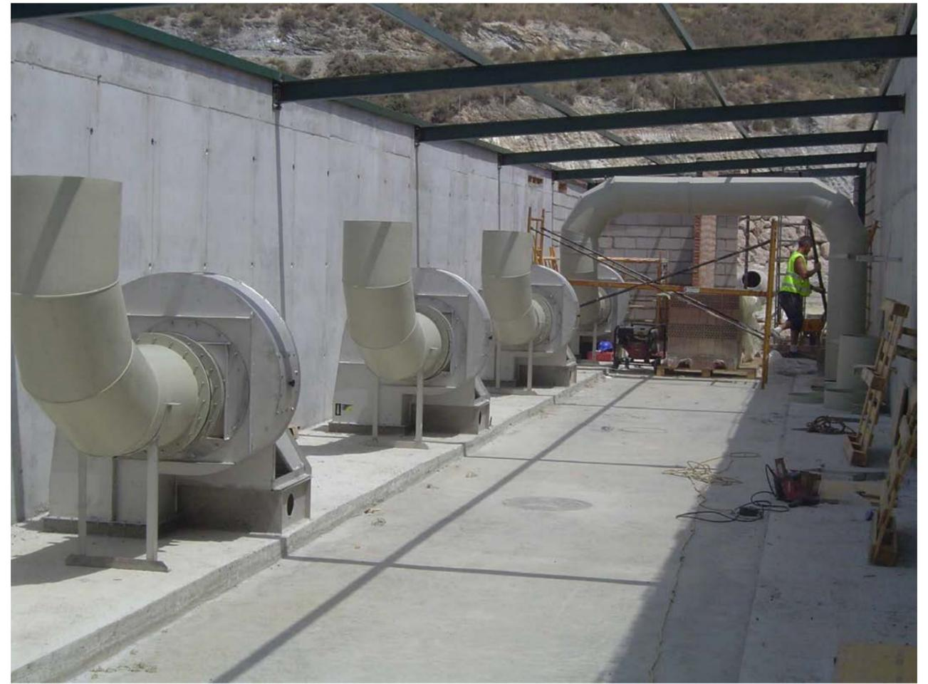
Aireación en planta de compostaje
