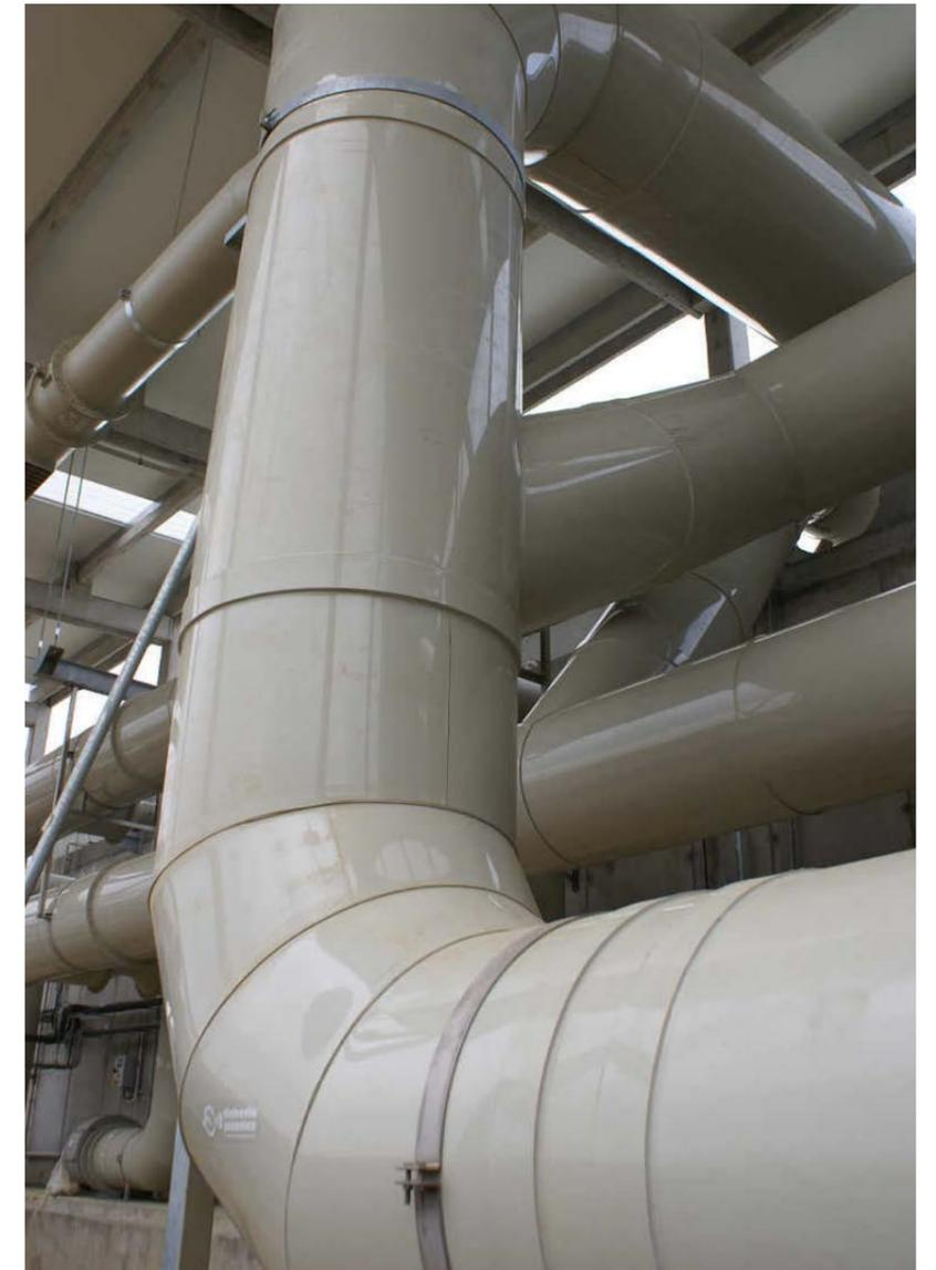
Aireación en planta de compostaje
